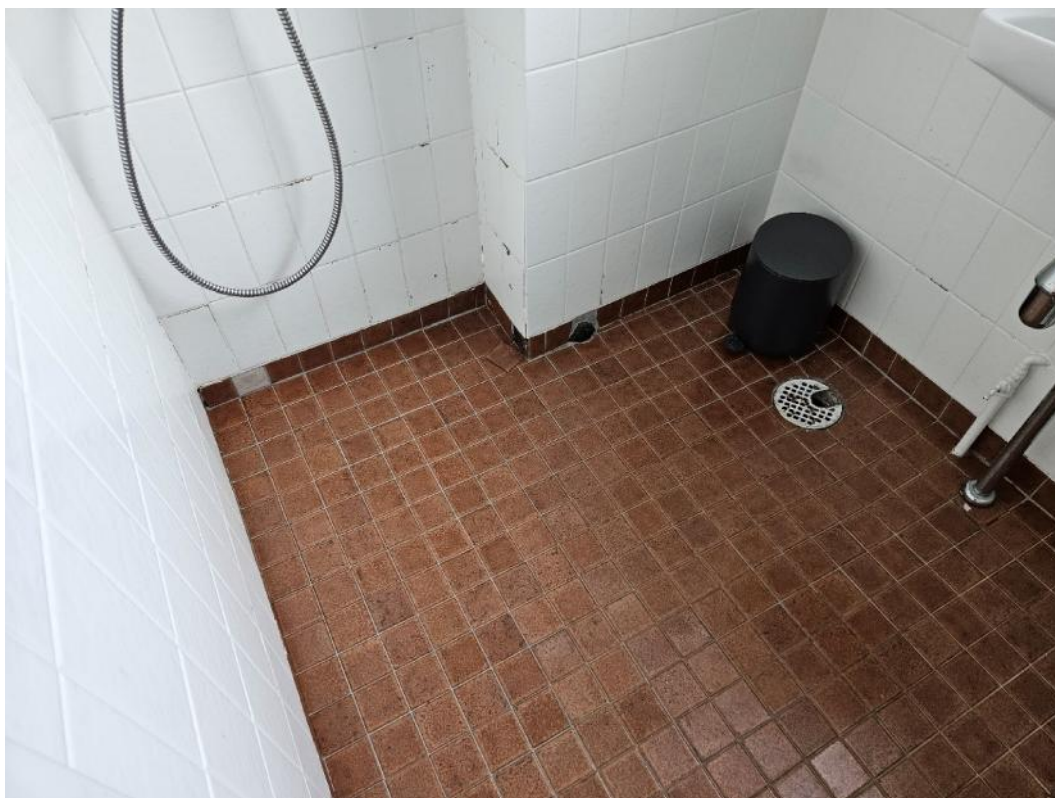
Figure 20: flísar eru í stöðum leysir frá undirlagnum
