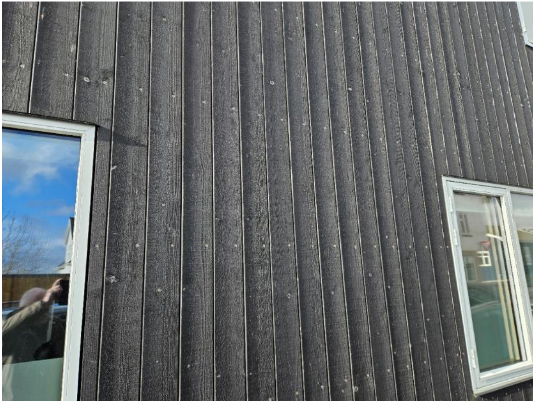
Figure 5: timburklædningur manglar málaraviðgerð
