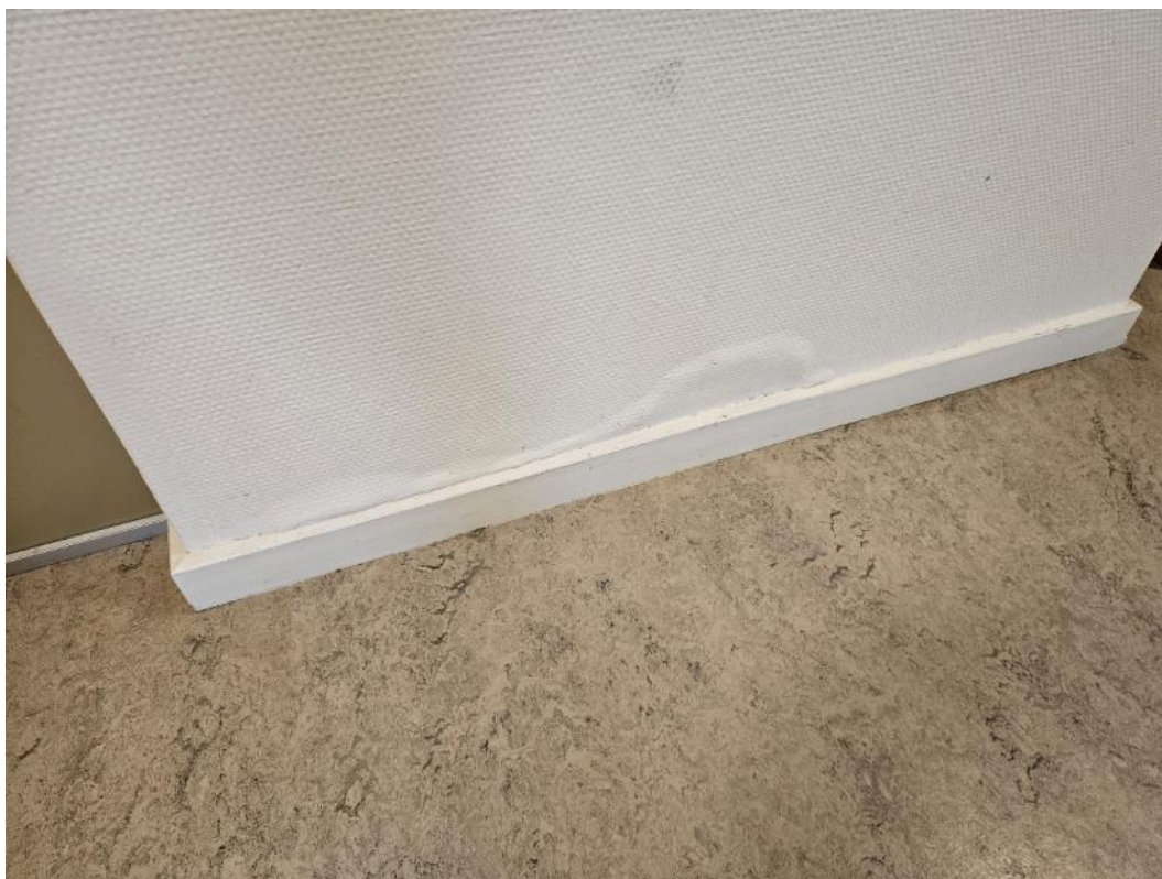
Figure 22: saltúttreingingar at síggja aftanfyri tapetið
