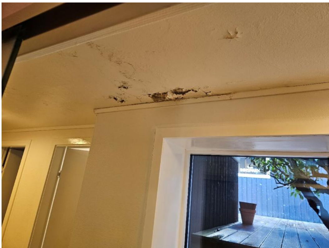
Figure 18: spor eftir leka í gongini uttanfyri vesni
