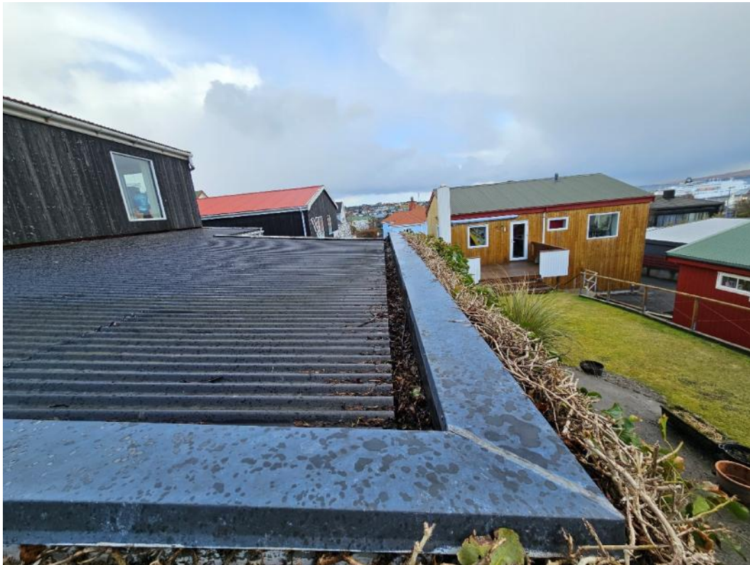
Figure 11: takrenna treingir til at verða reinsað
