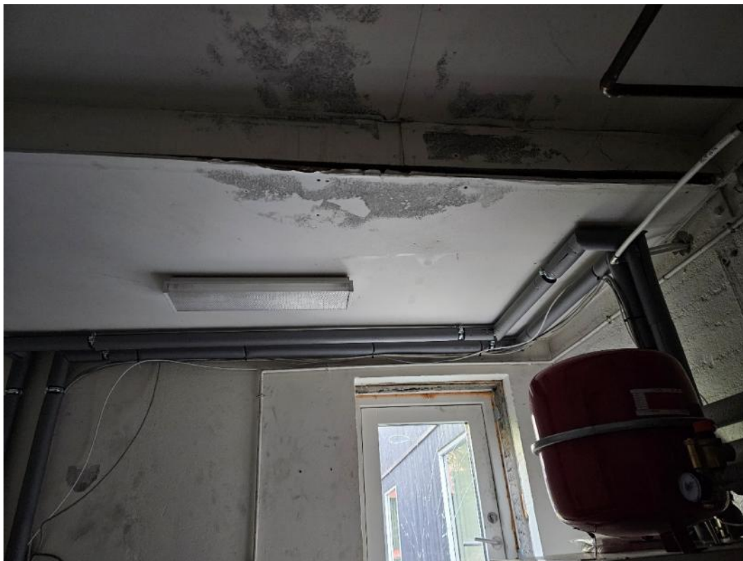
Figure 17: spor eftir leka í teknikrúmi
