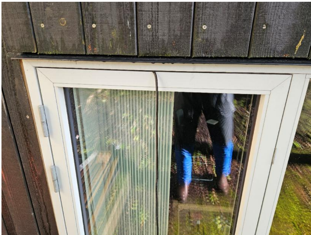
Figure 13: pakningar á síðuhongdu vindeygum eru í stöðum leysir
