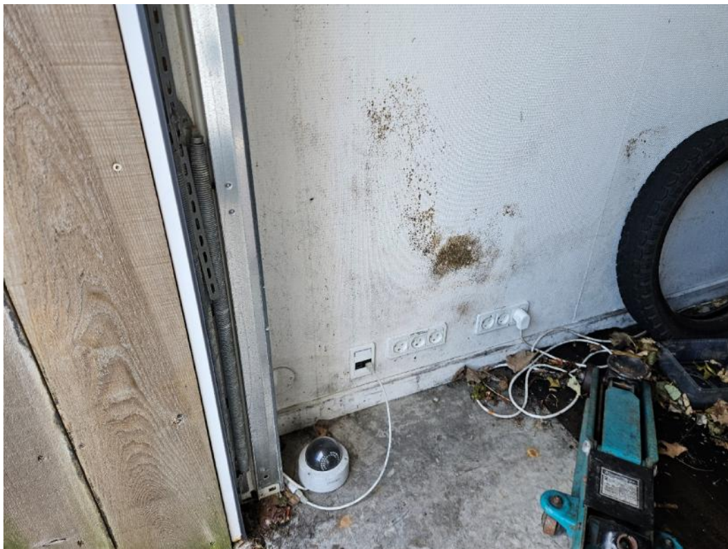
Figure 19: myrkur plettur á útveggi í garasjuni
