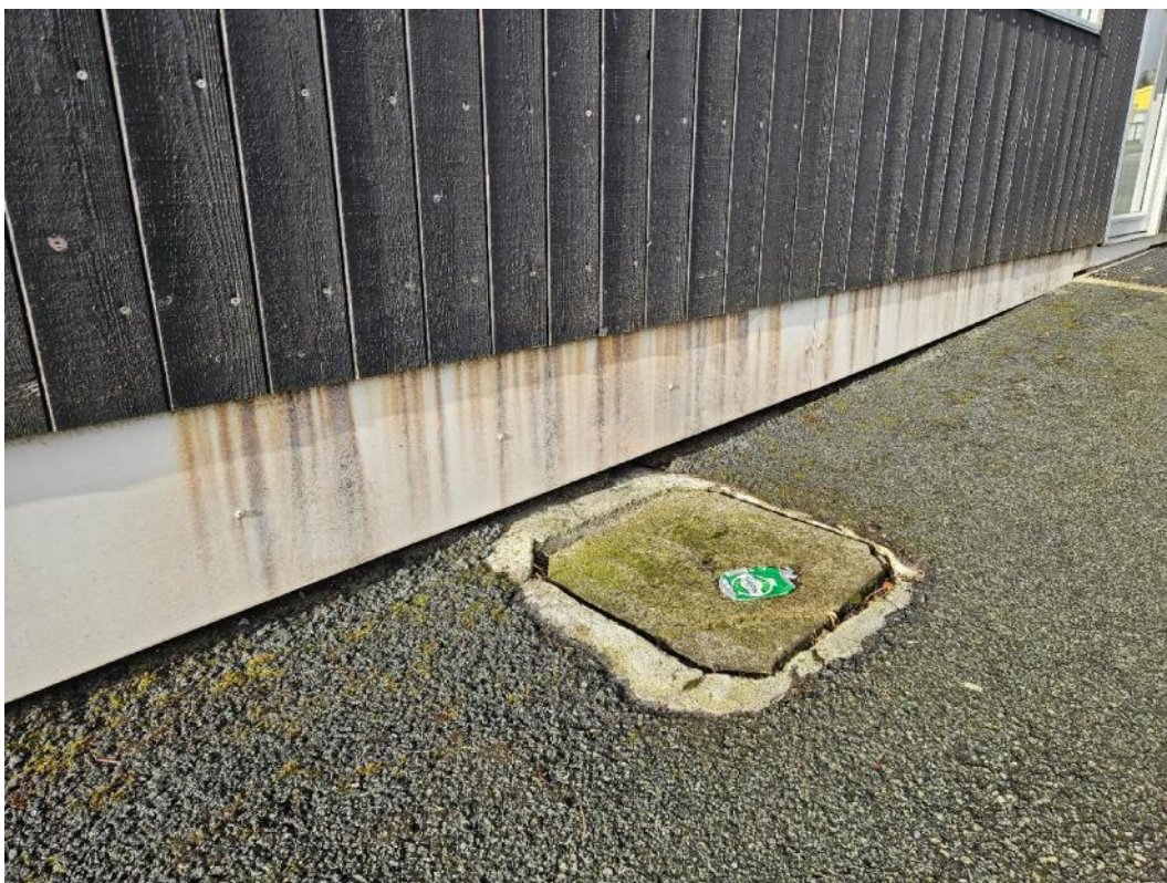
Figure 6: manglandi glopp millum timburklædning og sokkulplátu. Sokkulpláta dálkast av timburklædningi
