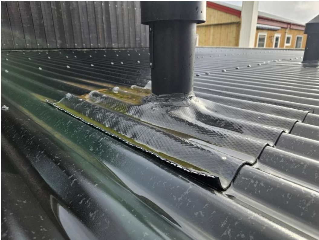
Figure 9: ventilatíónshettur eru settar niður á tekjuna, at síggja til ein ivasom loysn?
