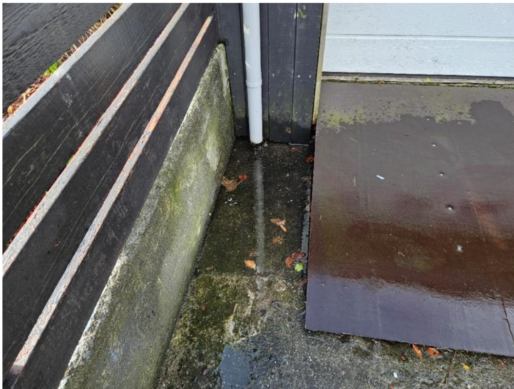
Figure 15: einkultir rennustokkar eru ekki leiddir burtur frá bygninginum
